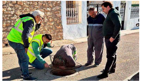
Las obras de mejora de las redes de agua de Huete avanzan a buen ritmo. / AYTO HUETE
