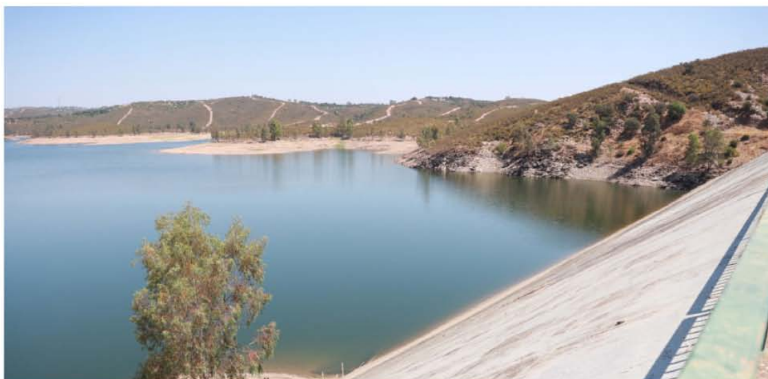
Agua.- AEOPAS pide planes de gestión del riesgo de sequía y otro de reducción de fugas con una subvención del 100%
